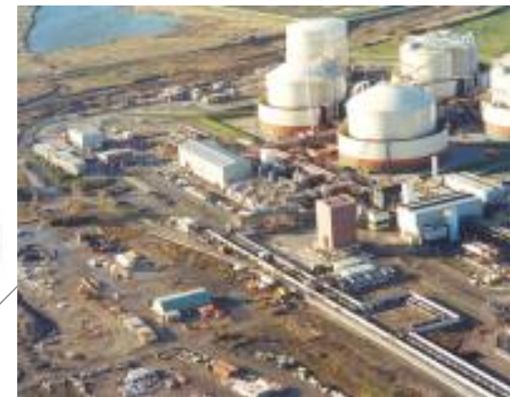
Isle of Grain LNG Terminal in Kent
